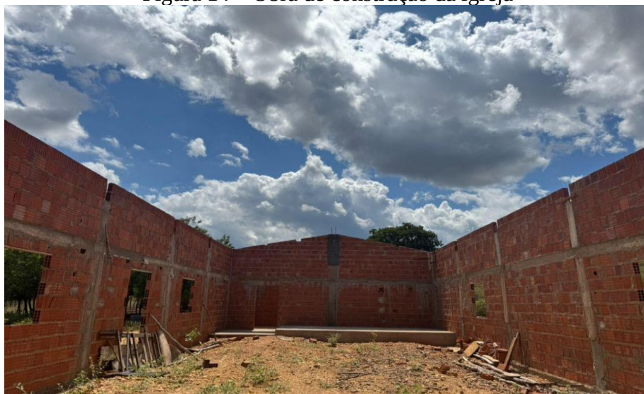
Figura 14 – Obra de construção da igreja
