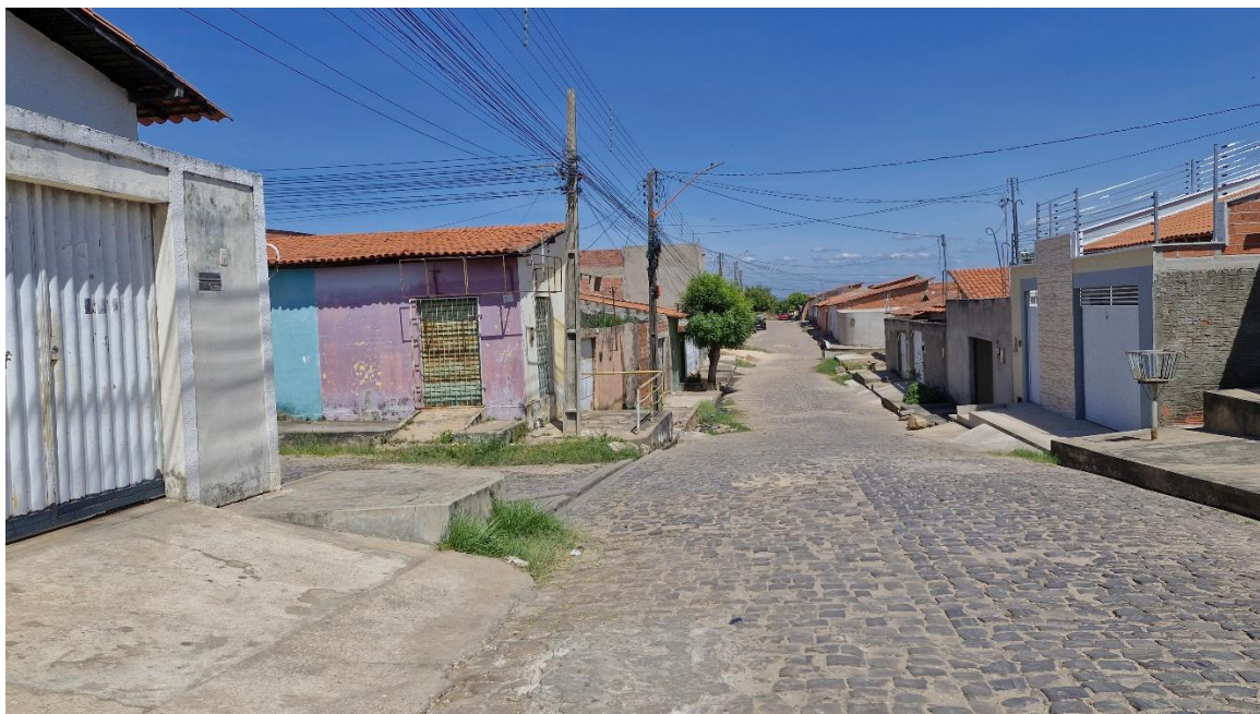
Figura 37 - Registro identificando a ausência de acessibilidade o Residencial Betinho
