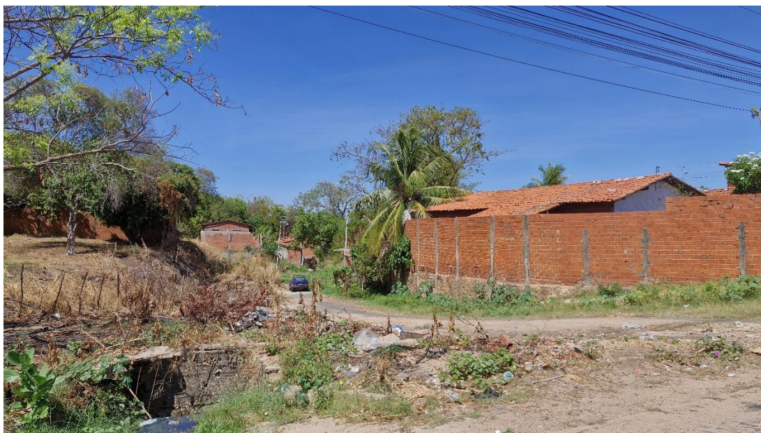
Figura 43 - Acesso à Área Verde 03
