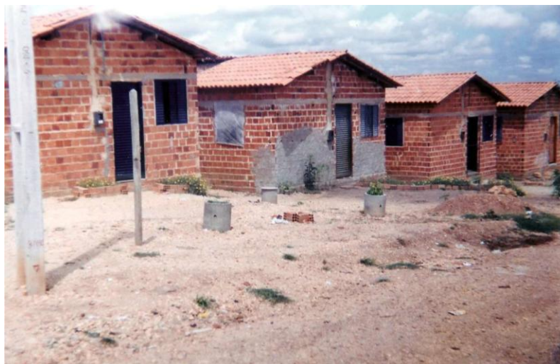
Figura 8 - Registro da Prefeitura de Teresina durante a construção de casas do Residencial Betinho
