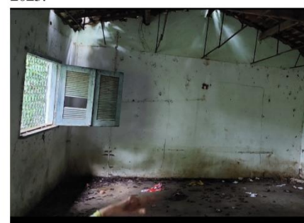
Figura Vista da sala de aula, na lateral da porta de entrada. 2023.
