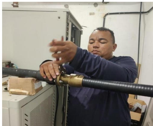
Foto 37 - Aílton Cesar realizando manutenção no transmissor da emissora
