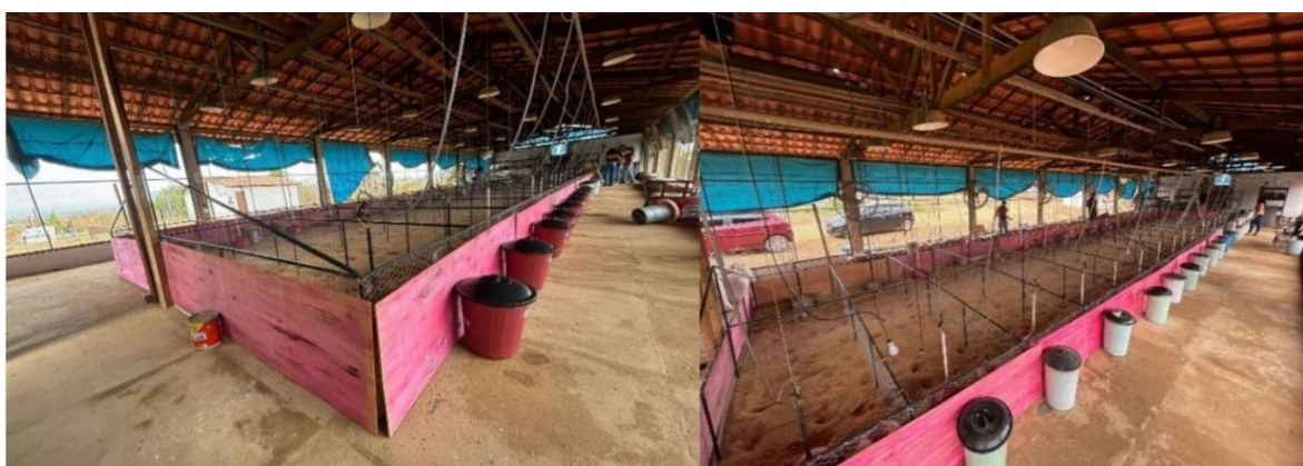
Figura 1 – Galpão convencional localizado no Colégio Técnico de Bom Jesus, UFPI.
