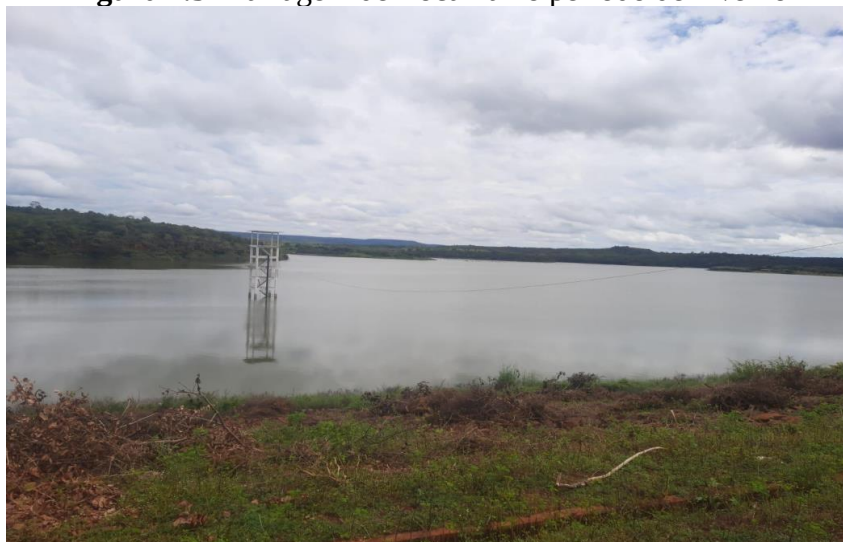
Figura 7.3- Barragem de Bocaina no período de inverno
