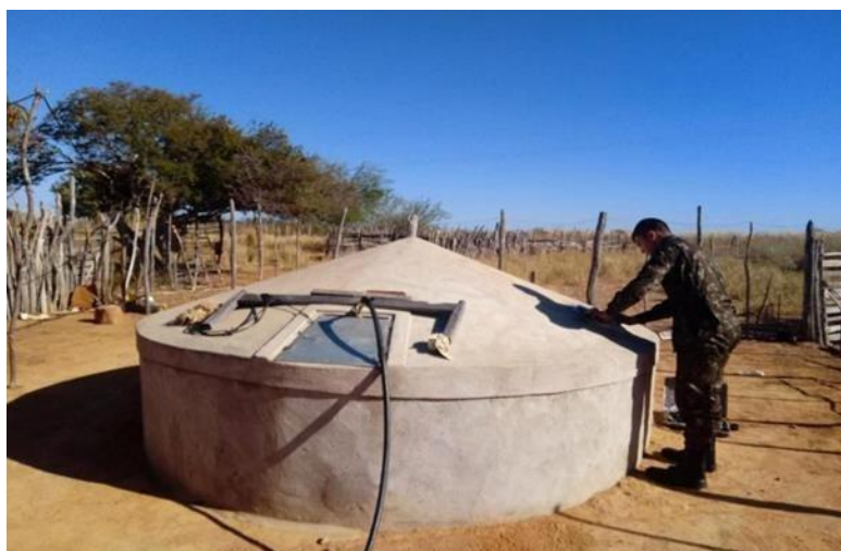
Figura 5.6 – Cisterna instalada na zona rural do Semiárido Piauiense
