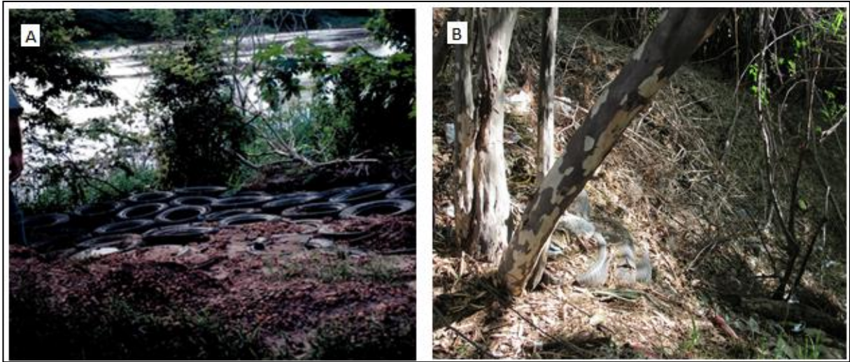
Em (A) durante o processo de construção e (B) a atual situação Foto: A. Muller (2000); Albert Isaac Gomes Viana (2018)
