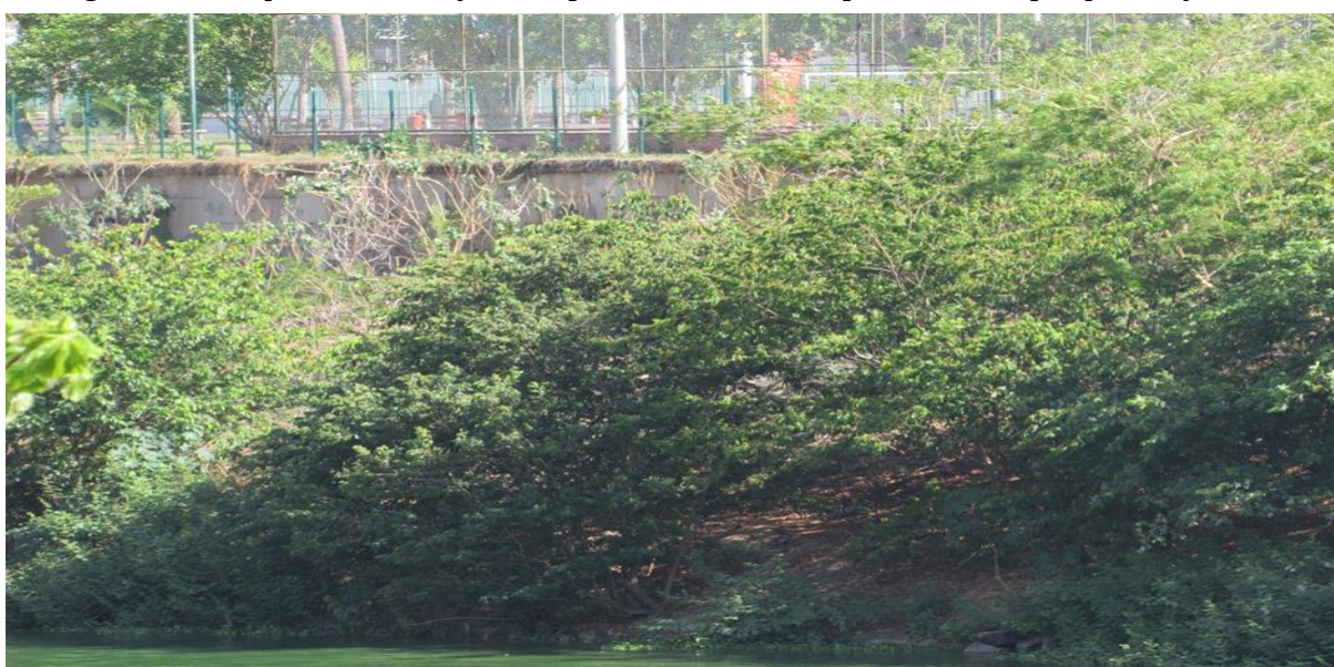
Figura 51 - Dique de contenção dos processos erosivos próximos do parque Potycabana
