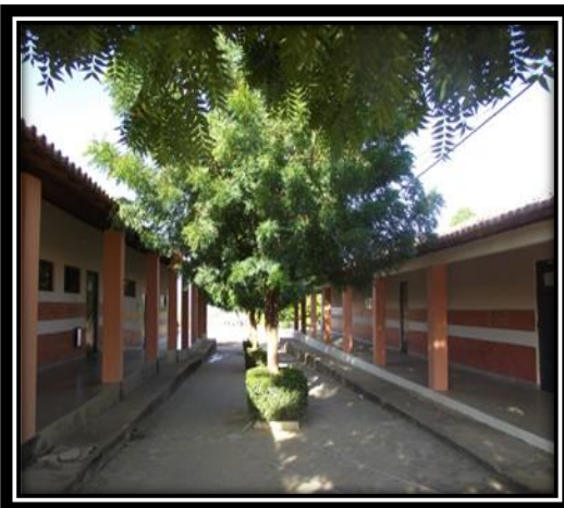
Fig. 02: Bloco de Salas de Aula
