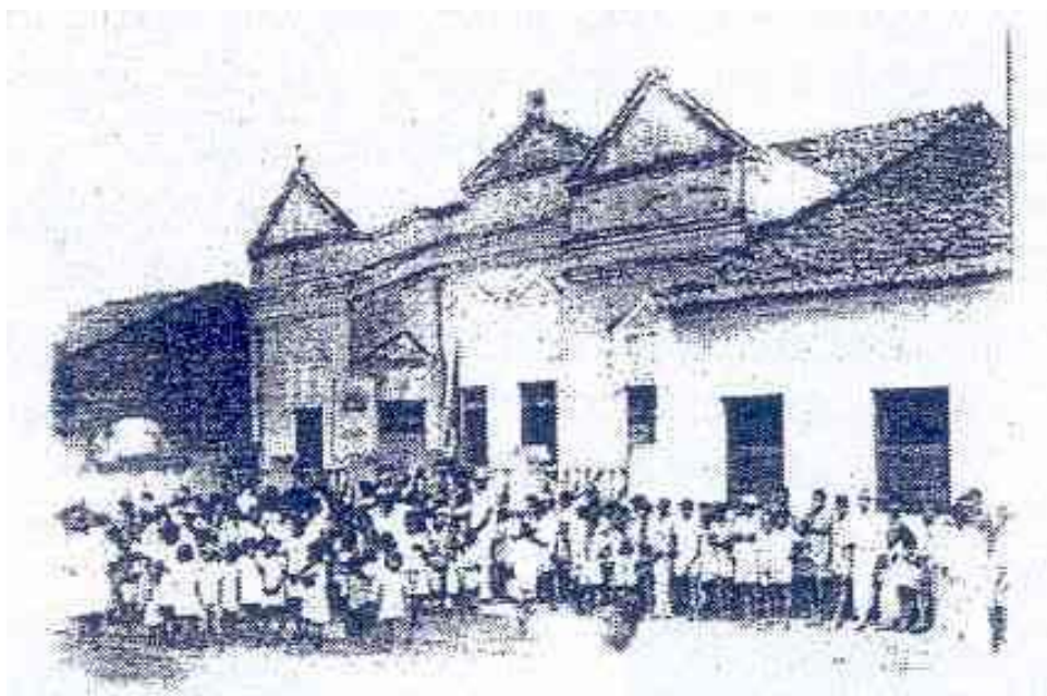
Figura 9 – Fachada do Hospital de Caridade de Floriano na década de 1920.
