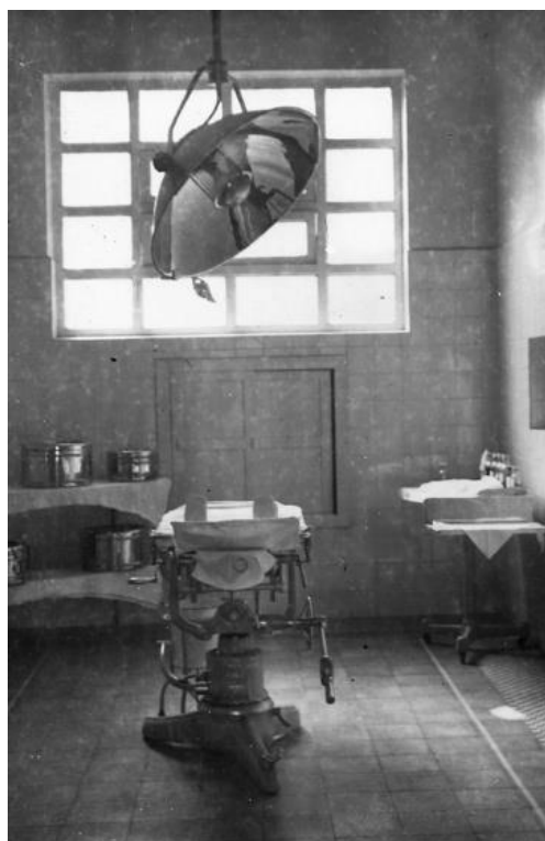
Figura 28: Sala de Operações Maternidade Marques Basto. Fonte: SOCIEDADE DE PROTEÇÃO À MATERNIDADE E À INFÂNCIA DE PARNAÍBA. Disponível em: http://spmip.org.br/ . Acesso em: 11 maio 2023.
