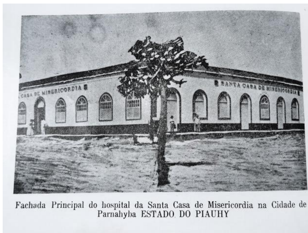
Figura 5: Fachada do hospital da Santa Casa de Misericórdia de Parnaíba. Fonte: FOLGUEIRA, M. R. Album Artístico Commercial do Estado do Piahy . Teresina: [s. n.], 1987.
