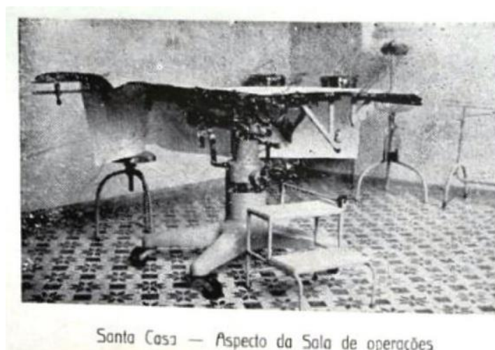
Figura 20: Aspecto da sala de operações – Santa Casa de Misericórdia. Fonte: SANTA CASA de Misericórdia de Parnaíba. Almanaque da Parnaíba , Parnaíba, ano 17, p. 307-309, 1940.
