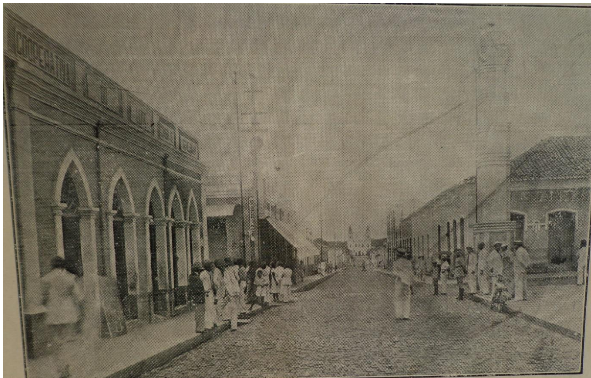
Fotografia 15 – Serviço de calçamento da rua Simplício Mendes e o Regulador Público inaugurados em 1938.
