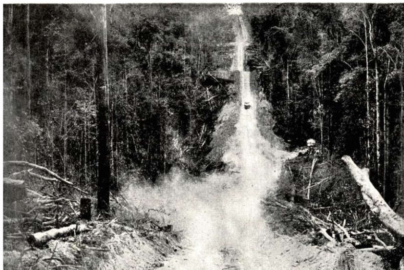
Figura 8 – Trecho da Rodovia Belém-Brasília
