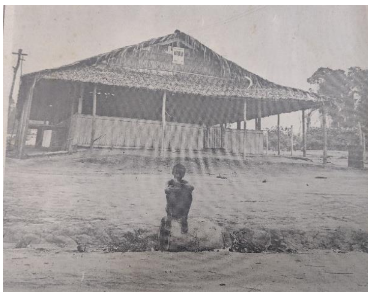
Figura 40 – Escola construída pelo Projeto João de Barro em Buriticupu
