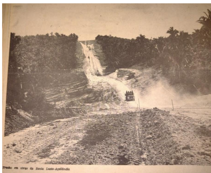
Figura 29 – Trecho em obras da Santa Luzia-Açailândia (BR-222)
