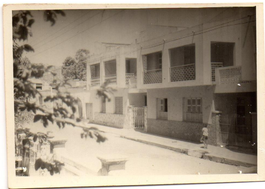
Foto 5 – Vista de frente da casa para a rua Rui Barbosa no centro de Teresina
