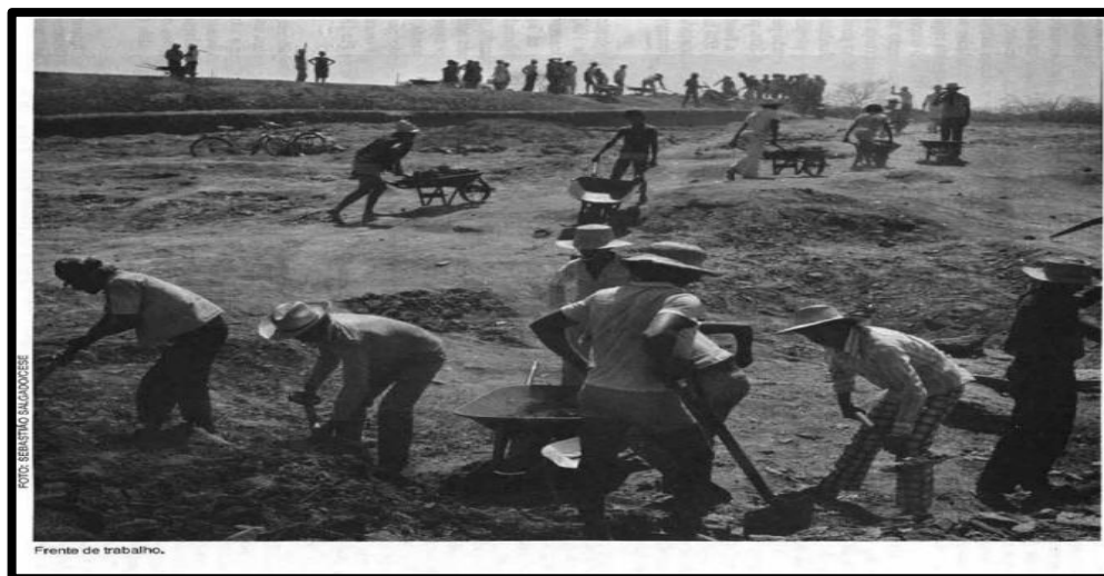
Figura 07 – Frente de trabalho – Fotografia de Sebastião Salgado da série “Trabalhadores”.
