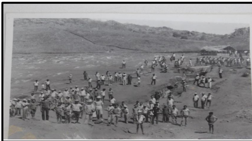
Figura 08 — trabalhadores na frente de trabalho da construção da Barragem de Fátima -1983 -Picos-PI.
