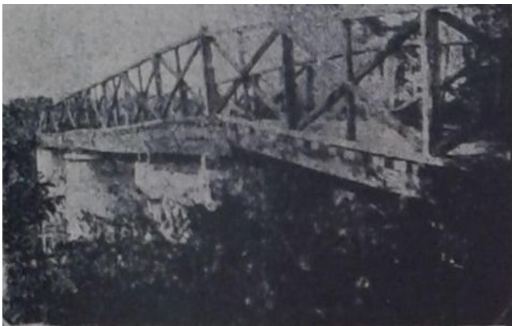
Imagem 16: Ponte de madeira sobre o rio dos Matos
