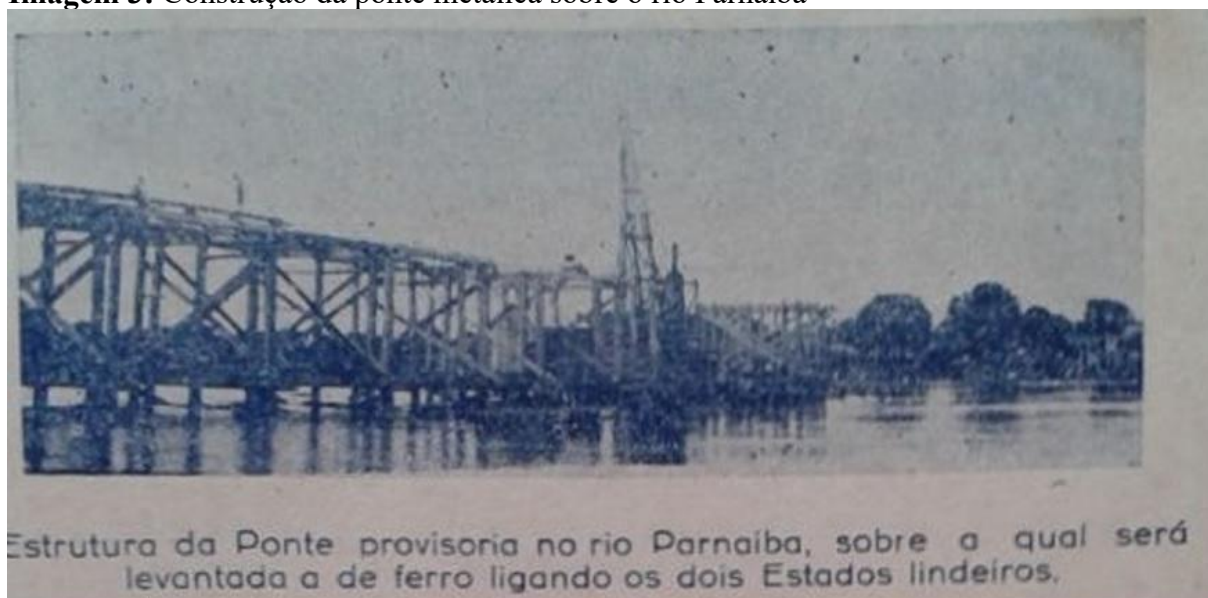
Imagem 3: Construção da ponte metálica sobre o rio Parnaíba
