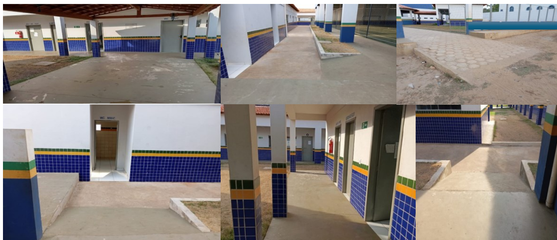
Figura 10 - Nova infraestrutura física da Escola Rochedo de Matões (MA) não atende as normas de acessibilidade arquitetônica definidas na LBI e na ABNT - NBR 9050
