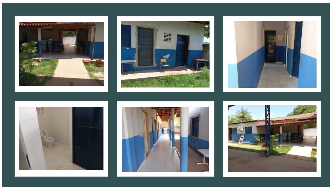
Figura 14 - Infraestrutura física da Escola Sabores do Campo de Altos (PI)
