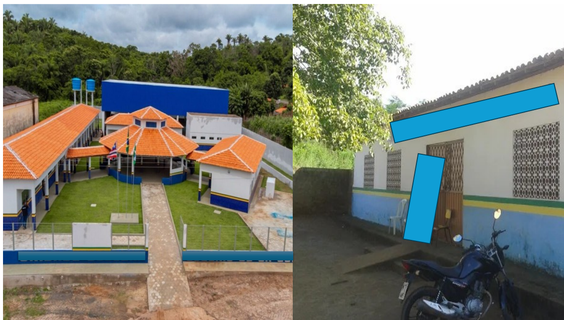
Figura 8 - Comparação da estrutura física do antigo prédio e do atual prédio da Escola Rochedo de Matões (MA)
