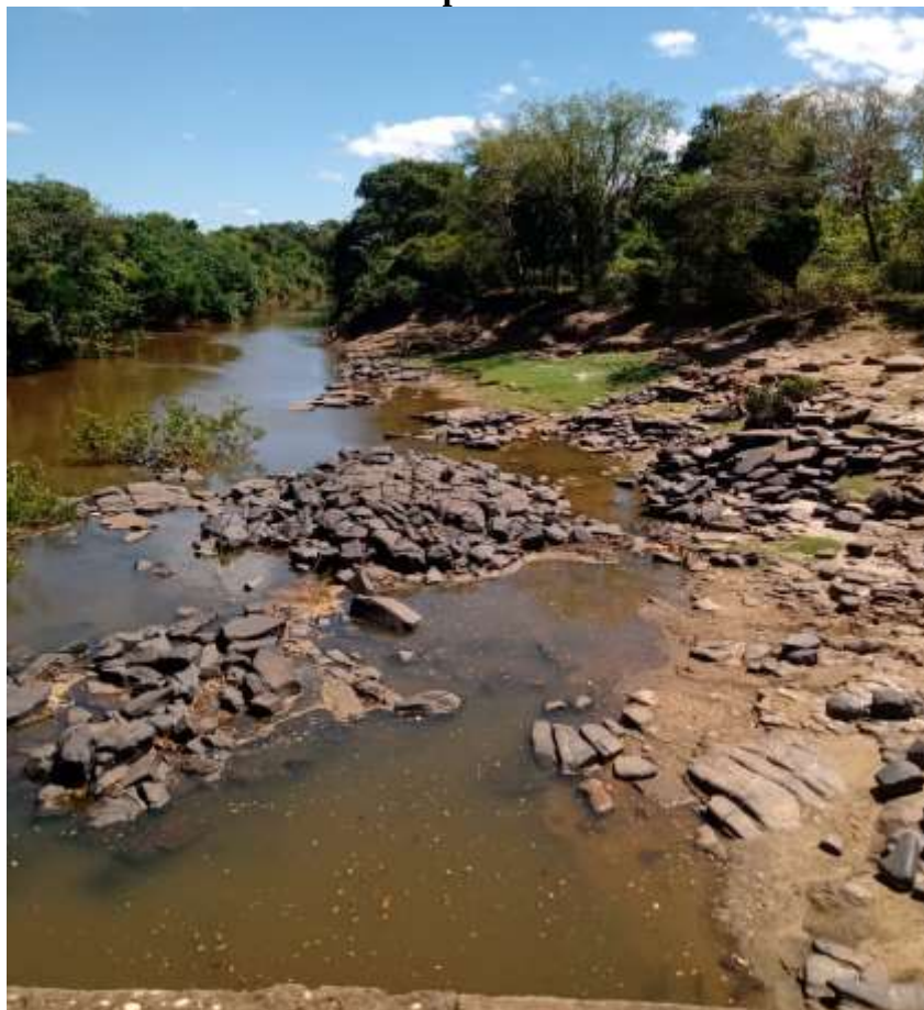
Figura 03 - Foto retirada de cima da ponte sobre o Rio dos Matos – Manga Iús
