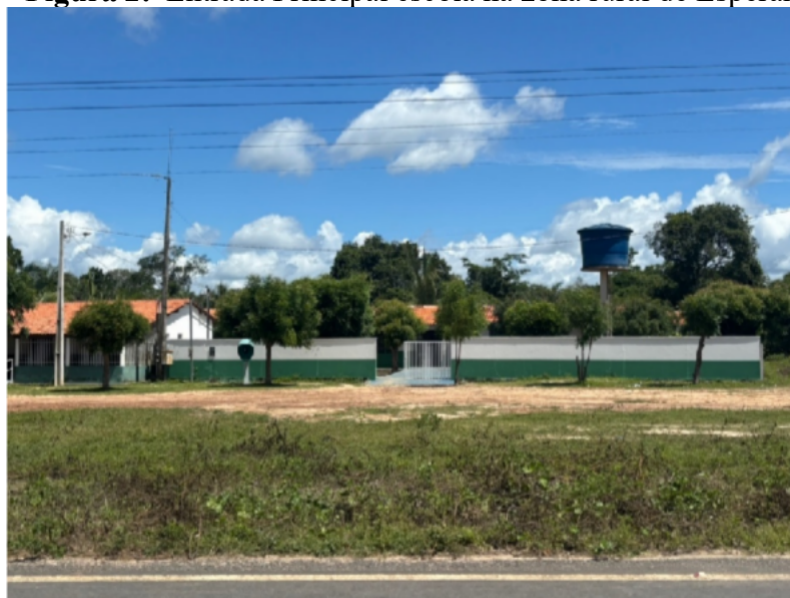
Figura 2: Entrada Principal escola na zona rural de Esperantina- PI
