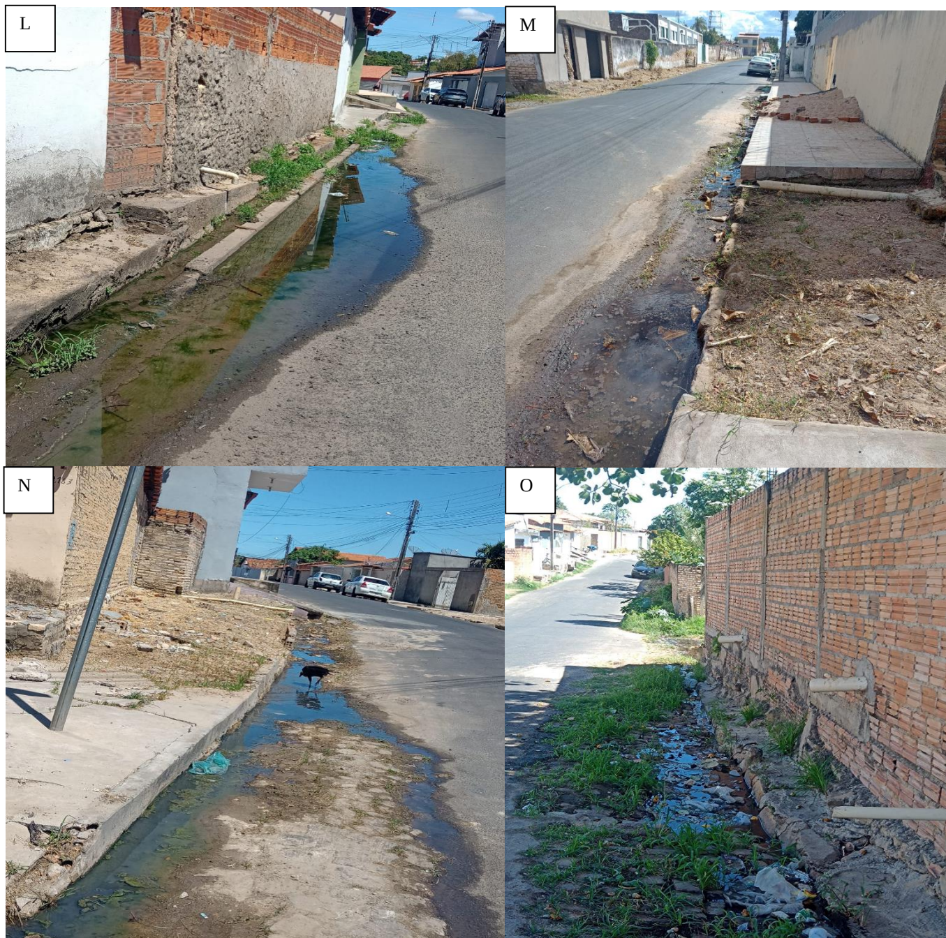
Figura 4 – Registros de esgoto lançado in natura diretamente nas ruas. L – Rua: Antonino Freire na periferia de Floriano-PI; M – Rua: Antônio Nascimento na periferia de Floriano-PI; N – Rua: João Chico na periferia de Floriano-PI; O – Rua: Frutuoso Pacheco periferia de Floriano-PI.
