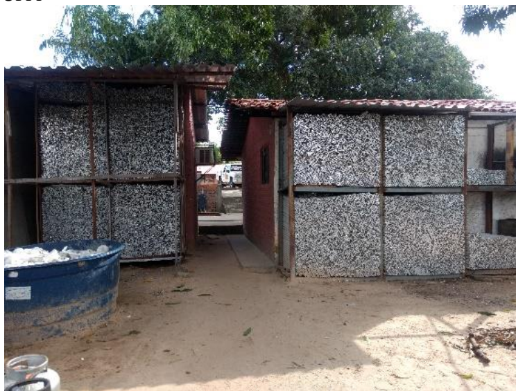
Figura 23 - Lâmpadas fluorescentes armazenadas –Setor de Transporte UFPI
