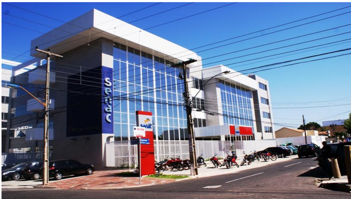
Figura 12 – Fachada do prédio do SENAC Av. Campos Sales- Teresina-PI
