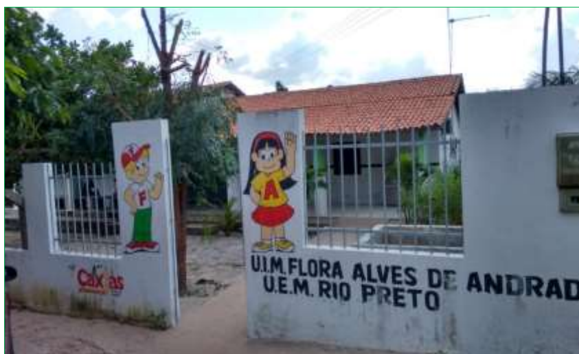
Figura 11- Fachada frontal da escola UIM Flora Alves de Andrade.
