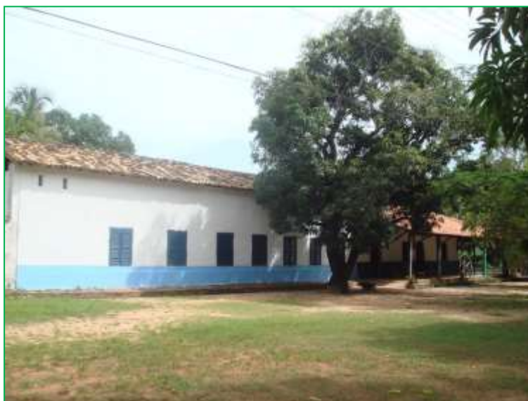
Figura 06. Casa Grande cedida para escola UIM Sinhá Castelo no povoado Engenho D'água no município de Caxias - MA
