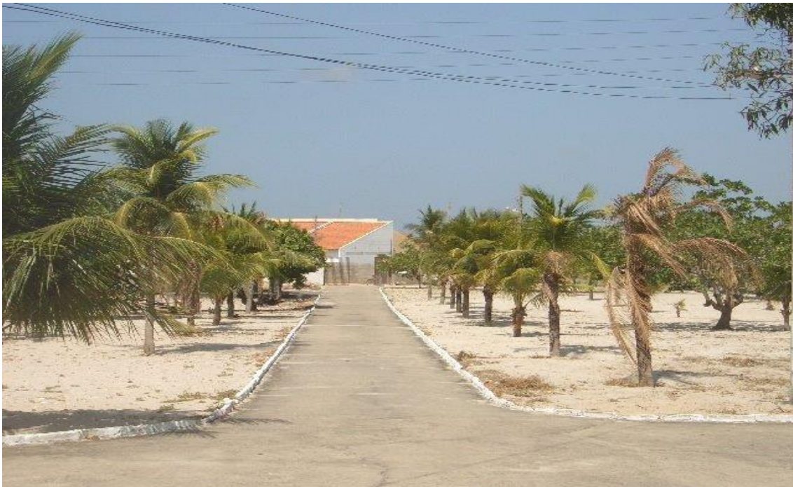
Figura 1 – Entrada do Hospital Colônia do Carpina
