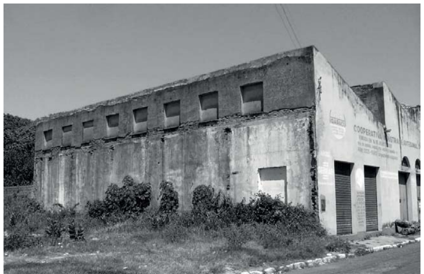
Figura 11- Vista lateral de prédio público a – Porto das Barcas, Parnaíba Fonte: Acervo da autora, 2015.
