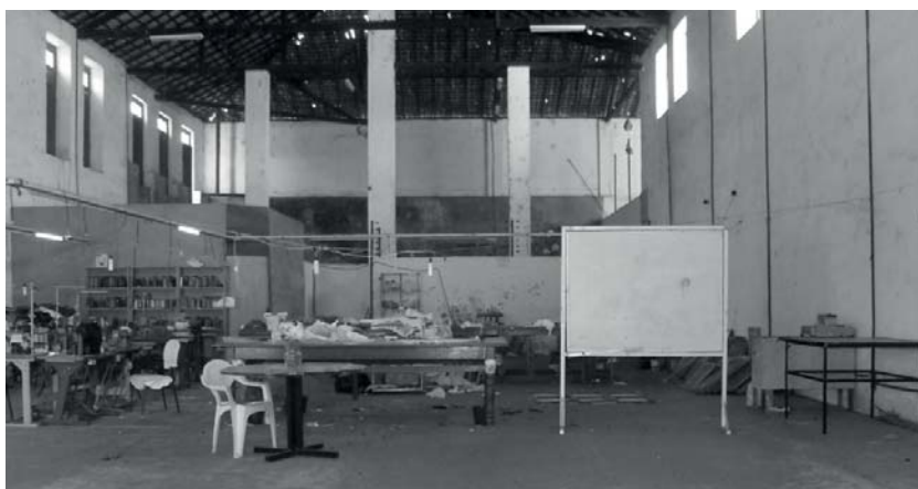
Figura 13. Vista interna de prédio público— Porto das Barcas, Parnaíba Fonte: Acervo da autora, 2015.
