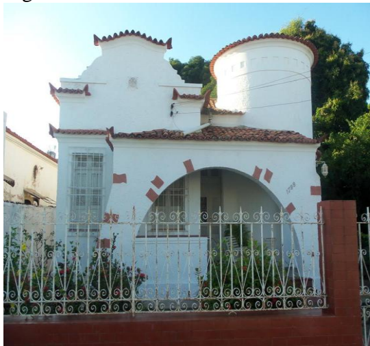
Figura 1 – Fachada da Casa Madalena
