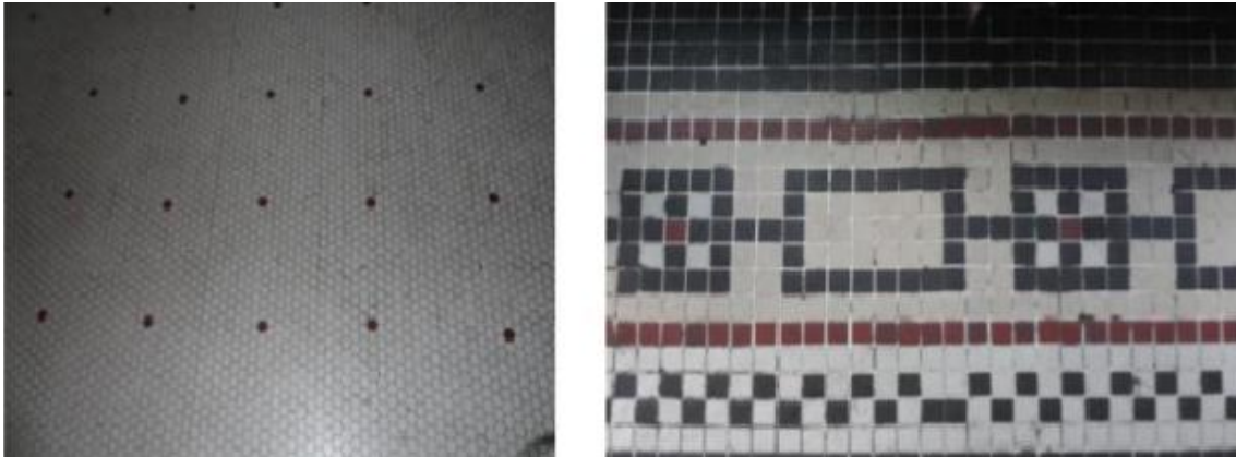
Figura 07 – Detalhe do piso cerâmico
