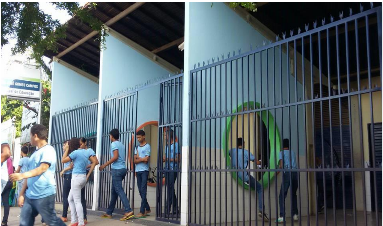
Fotografia 01: Vista frontal da escola
