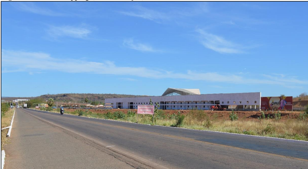
Figura 8 – Piauí Shopping (em construção) - BR 316
