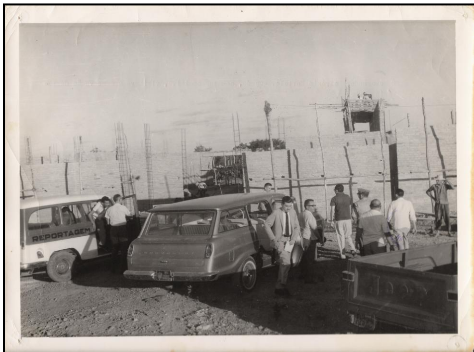
Figura 9: Visita do senador Petrônio Portela ao canteiro de obras da TV Clube Fonte: Fundação Valter Alencar.
