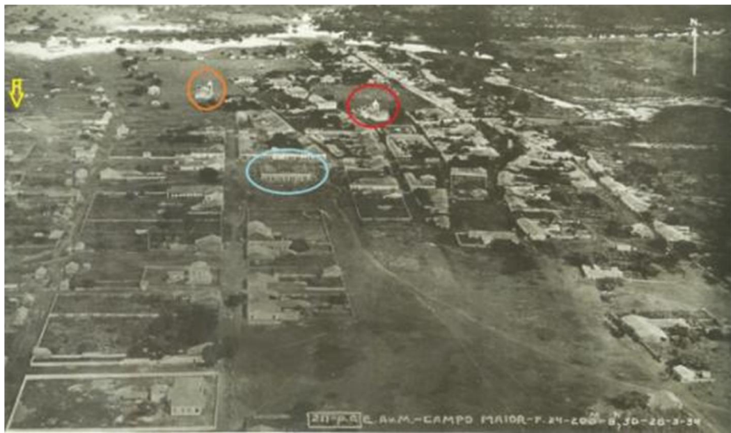
Figura 7 – Vista aérea da cidade de Campo Maior em 1934
