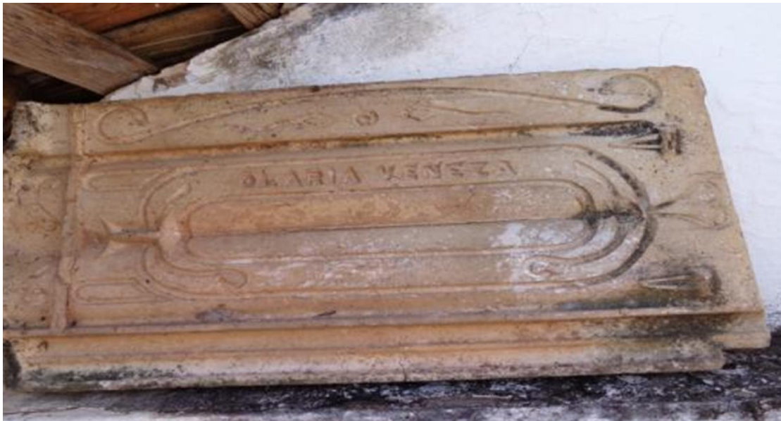
Figura 16 – Telha contendo inscrição do fabricante
