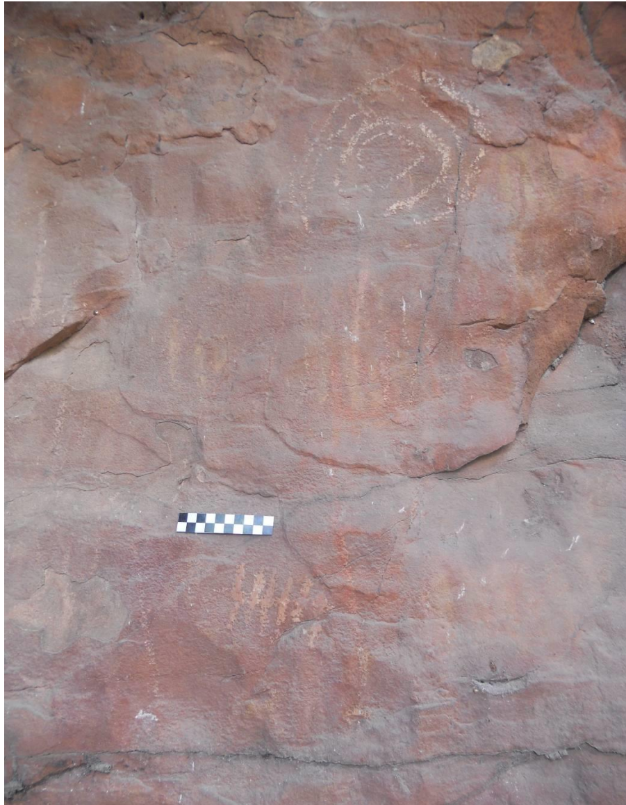
Figura 27– Pinturas vestigiais, encobertas por eflorescência salina. Sítio Lagoa de Cima. Autor: Rodrigues, 2013.
