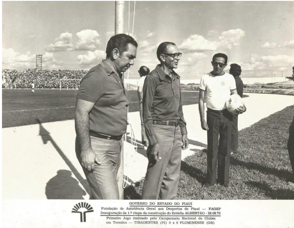
Figura 4: Inauguração da primeira etapa da construção do Estádio Albertão – 26.08.1973. Acervo do Arquivo Público do Estado do Piauí.
