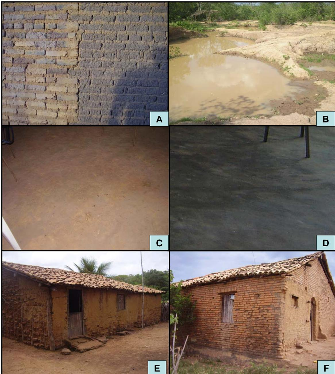
Figura 3: Olaria e tipos de construções no Quilombo dos Macacos, São Miguel do Tapuio – PI. **A** – parede construída de tijolos cozidos e tijolos crus. **B** – olaria da comunidade, **C** – piso de barro. **D** – piso de cimento. **E** – casa de taipa. **F** – casa de tijolo
