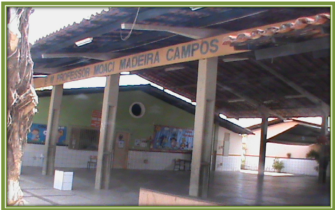
Figura 01 - Escola Municipal “Moaci Madeira Campos” – Pátio interno
