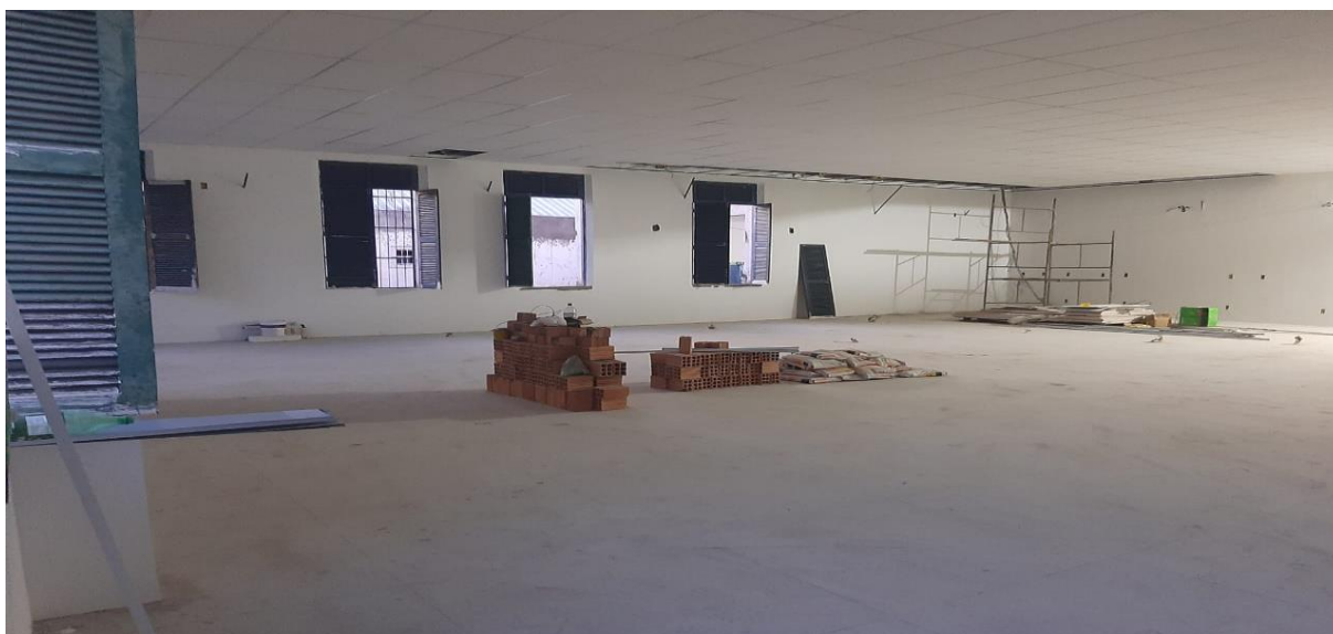
Figura 32-Interior do Prédio do GEAP modificado
