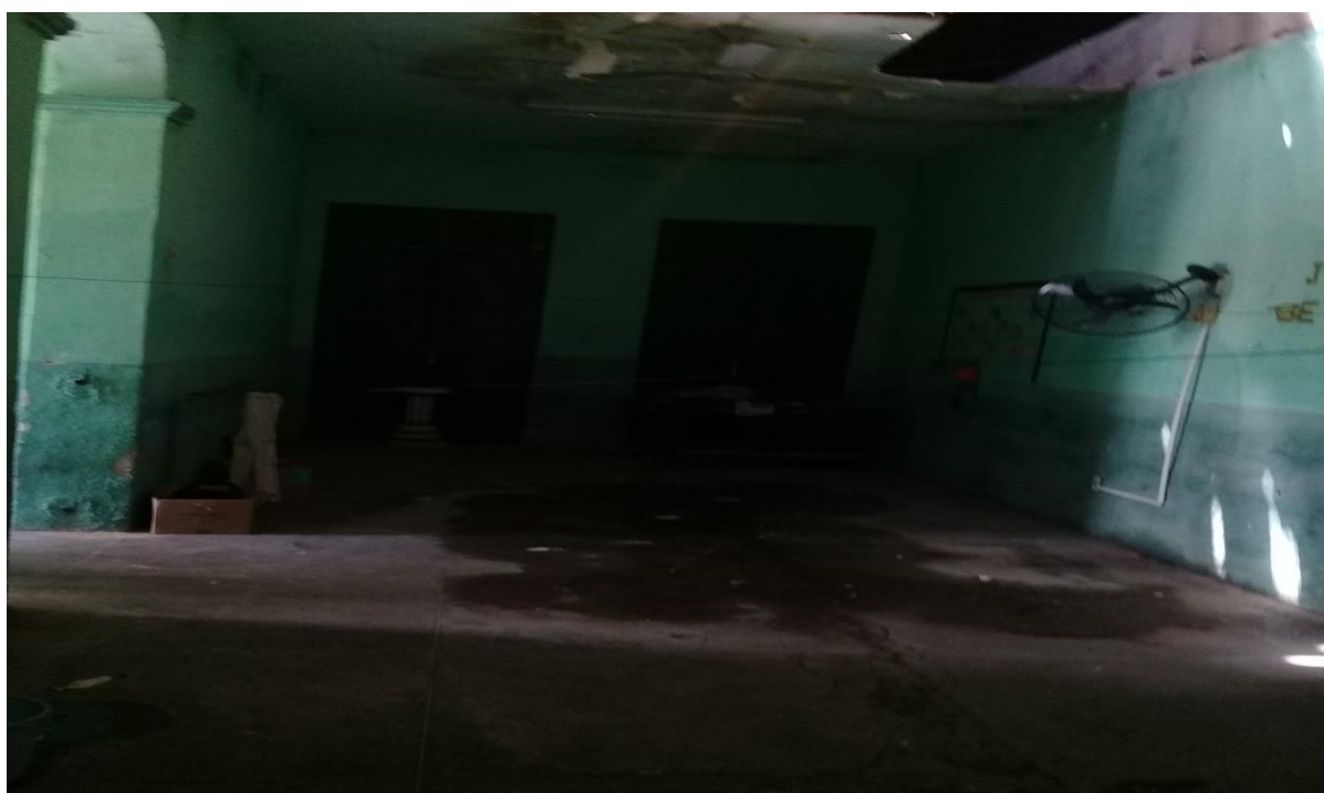
Figura 53-Interior do Prédio do GEAP original
