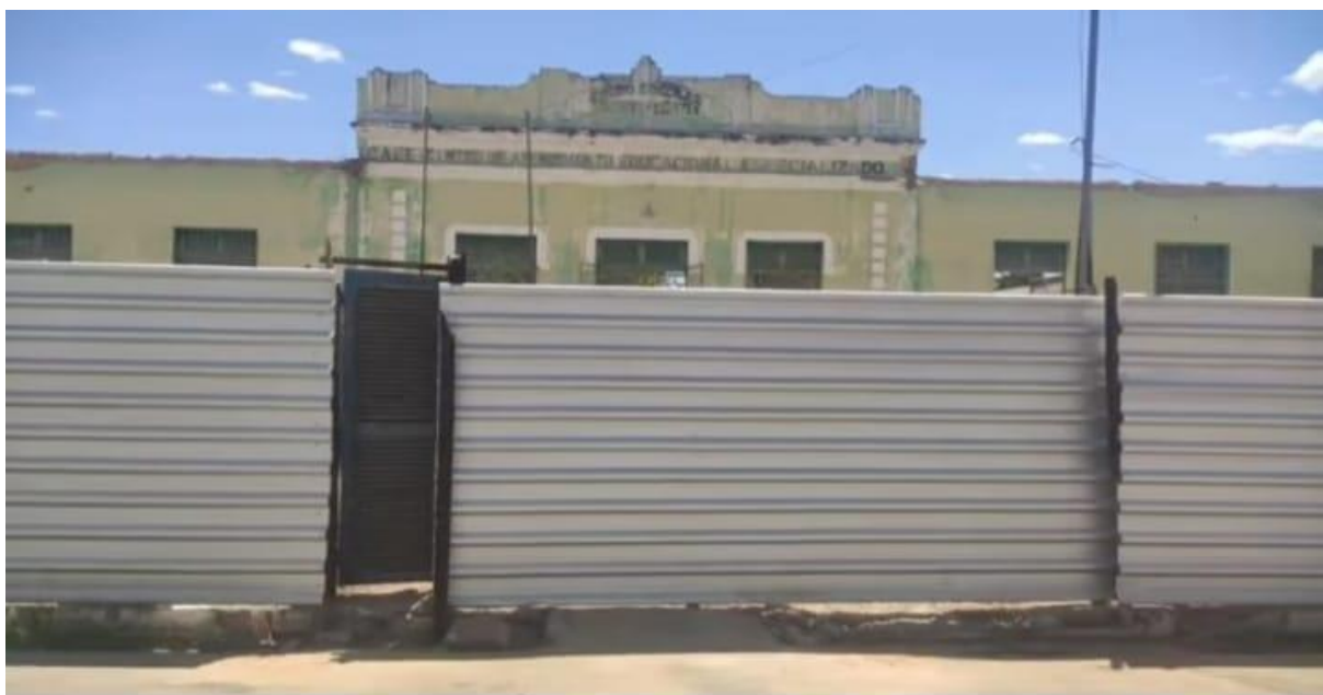
Figura 31- Faixada do Prédio do GEAP modificada.
