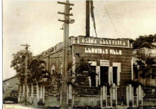
Figura 12 - Usina Termoelétrica (sem datação)
