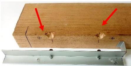
Foto 54 – Escavações na base
