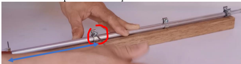
Foto 154 – Contato em 90^\circ Foto 155 – Apertando a abraçadeira de 150 mm
