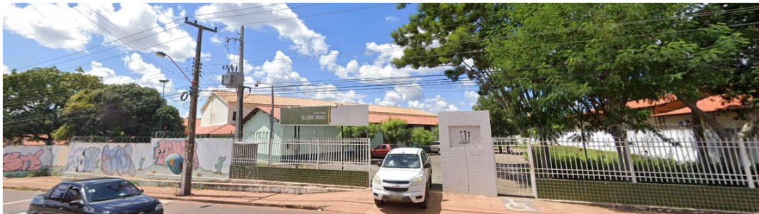
Foto 26: Fachada central do CETI Helvídio Nunes
