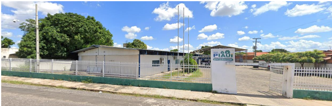
Foto 25: Fachada central do PREMEN Norte
