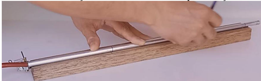
Foto 120 – Marcação das distâncias dos furos para abraçadeiras
