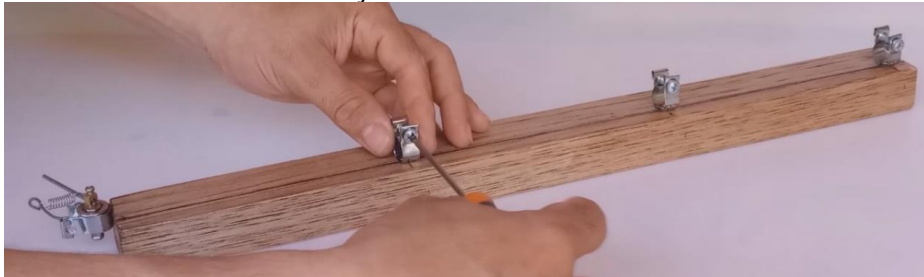
Foto 121 – Fixando as abraçadeiras na base
