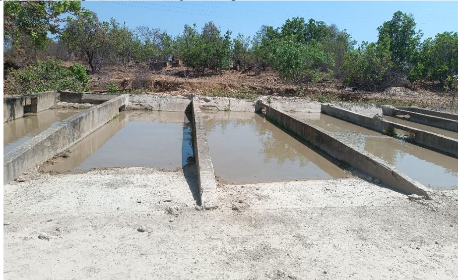
Figura 9 – Tanques de decantação da água utilizada no beneficiamento
