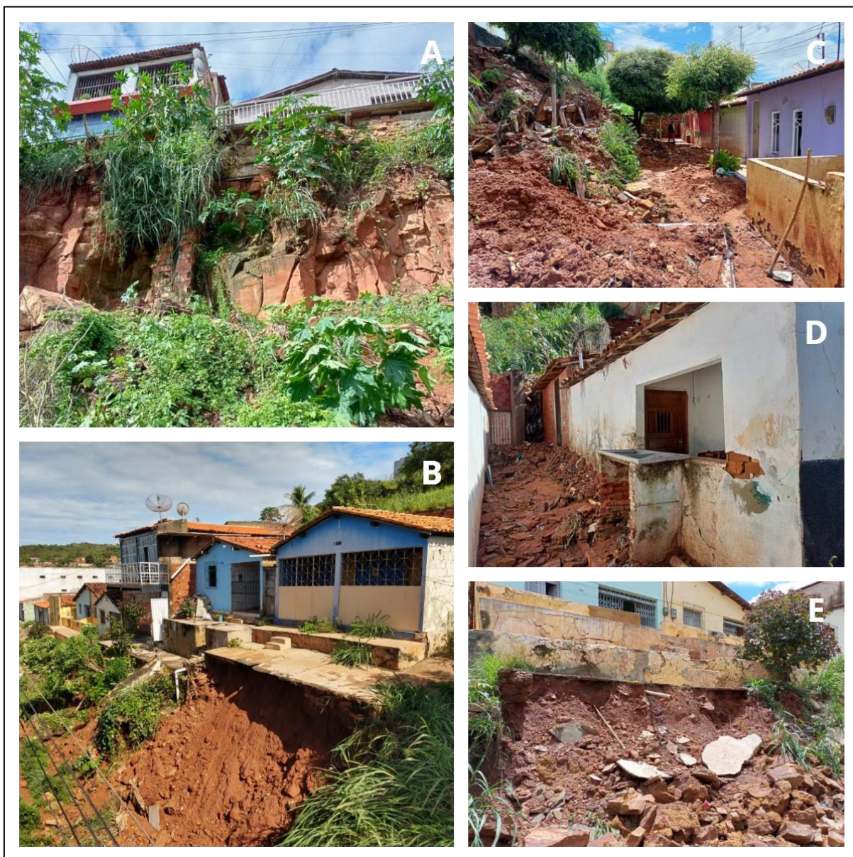
Figura 38 - Deslizamento de terra, com movimento de massa e rolamento de blocos em residências devido a fortes chuvas em Picos/PI. Em (A, B, C, D, E) bairro São José
