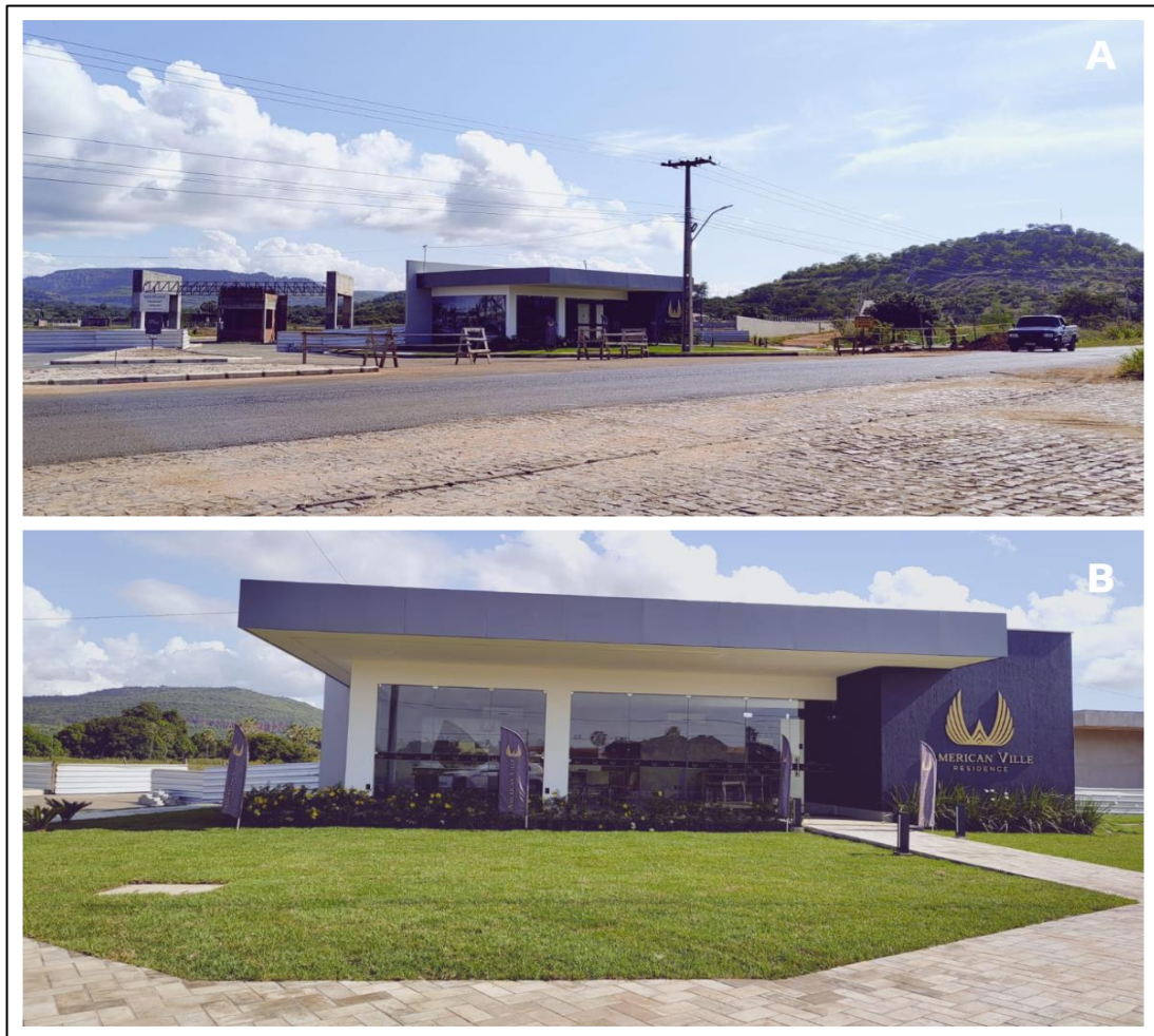
Figura 13 - Construção de um condomínio de alto padrão no bairro Ipueiras em Picos/PI
