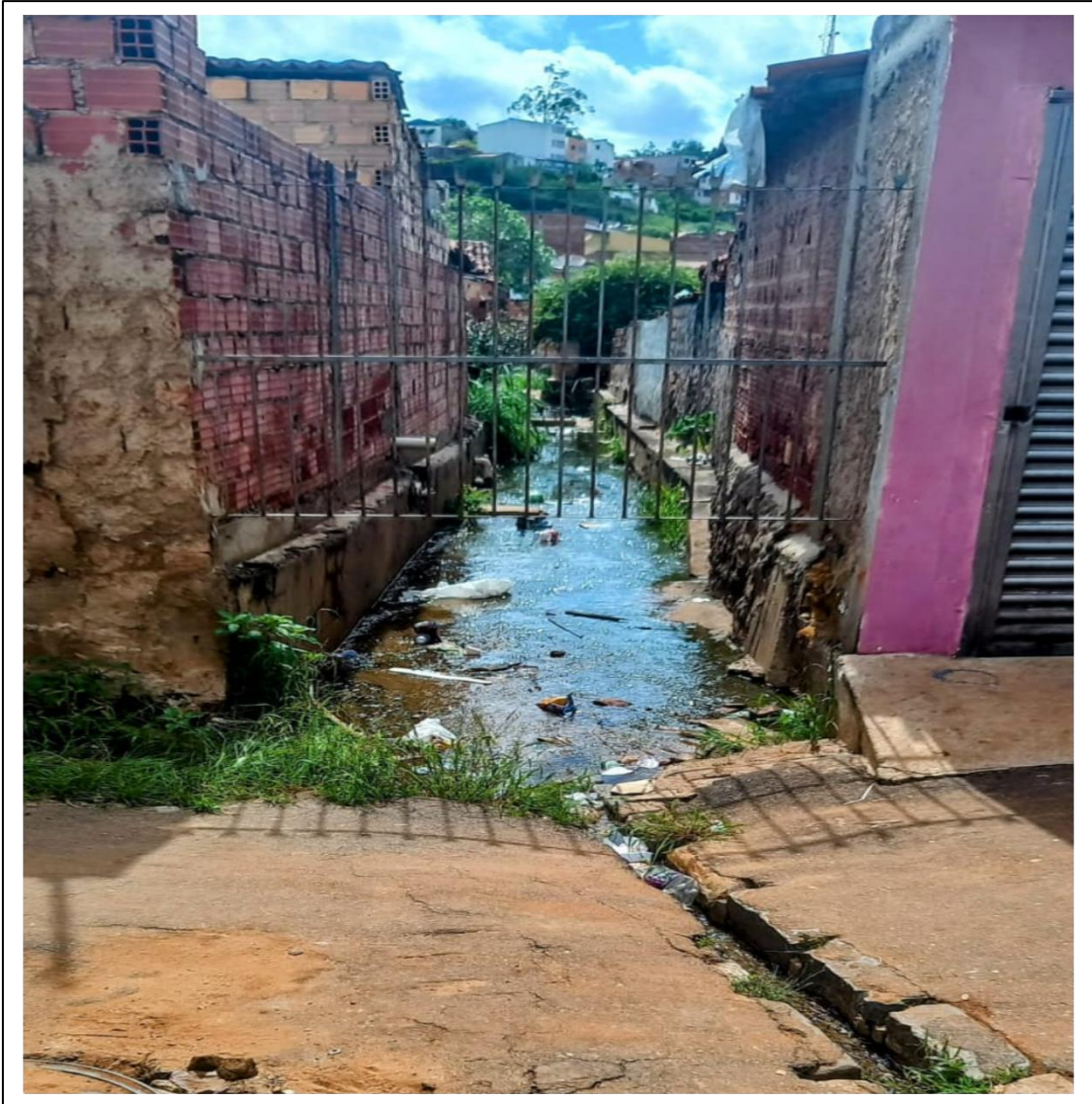
Figura 30 - Esgoto a céu aberto em um córrego entre residências no bairro Paroquial em Picos-PI
