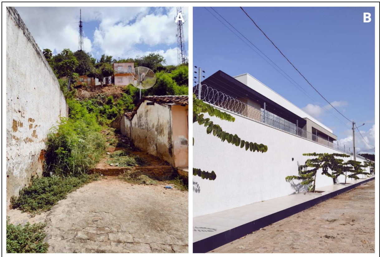
Figura 23 - Modificações urbanas realizadas por moradores no Bairro Paroquial (A) e Bairro Ipueiras (B), em Picos-PI
