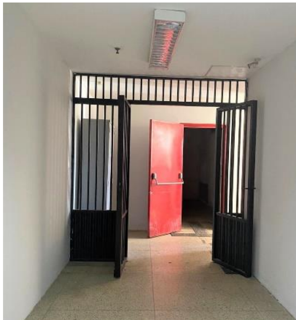
Figura 36- Instalação de grades para acesso a escada enclausurada
