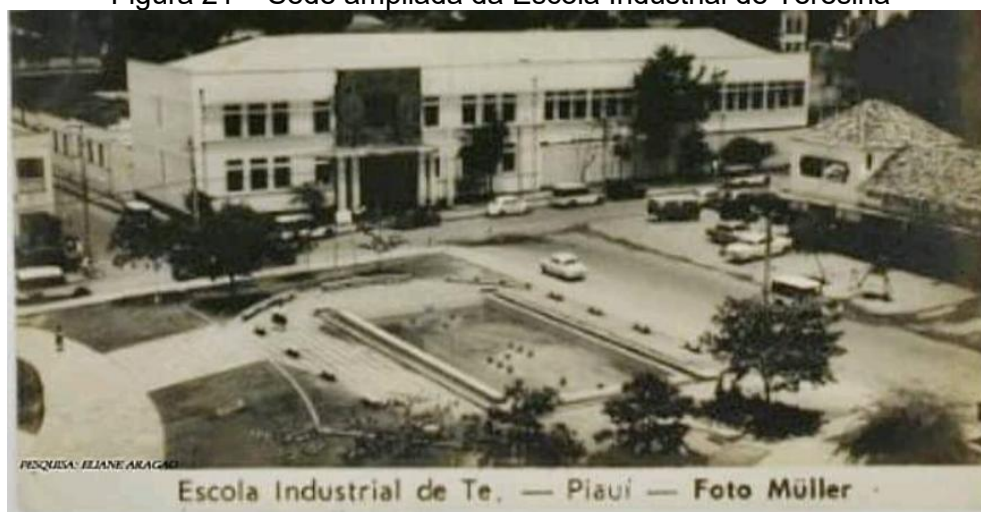
Figura 21 – Sede ampliada da Escola Industrial de Teresina
