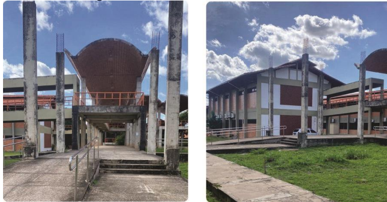
Figura 60: Conexão entre CT e CCN2
