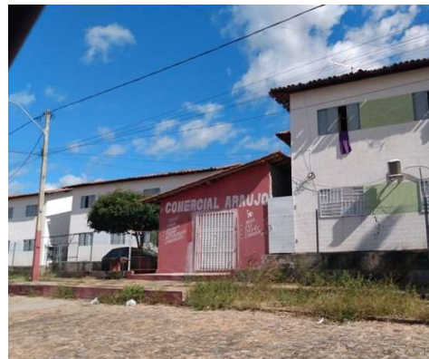
Figura 4.5: Residencial Angico, zona sul da cidade de Teresina.
