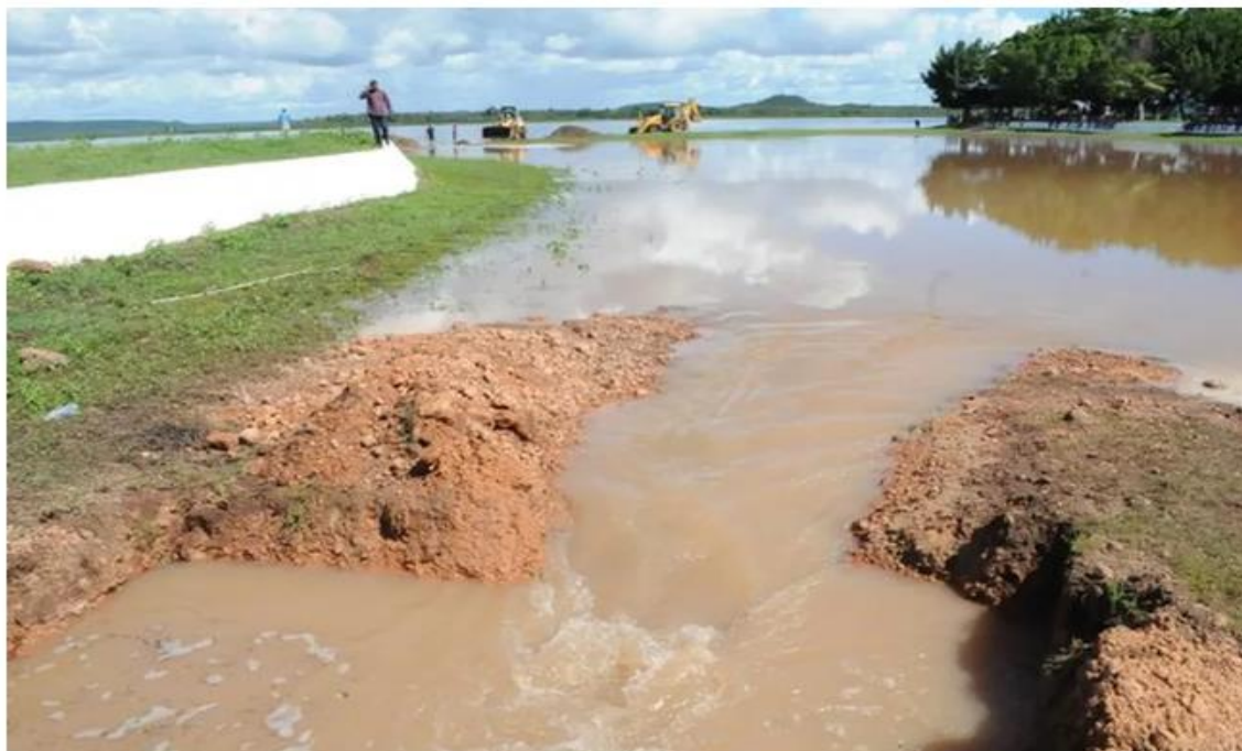
FIGURA 08: Obras emergenciais tentam diminuir vazão da barragem
