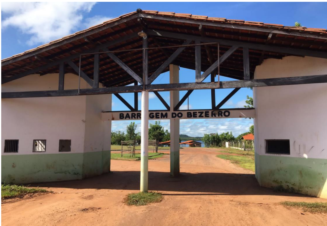
Figura 2: Entrada da Barragem do Bezerra
