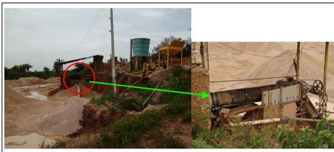
Figura 42 – Mecanismo de lavagem de seixo na franja urbana de Teresina e nas proximidades do bairro Aroeira.
