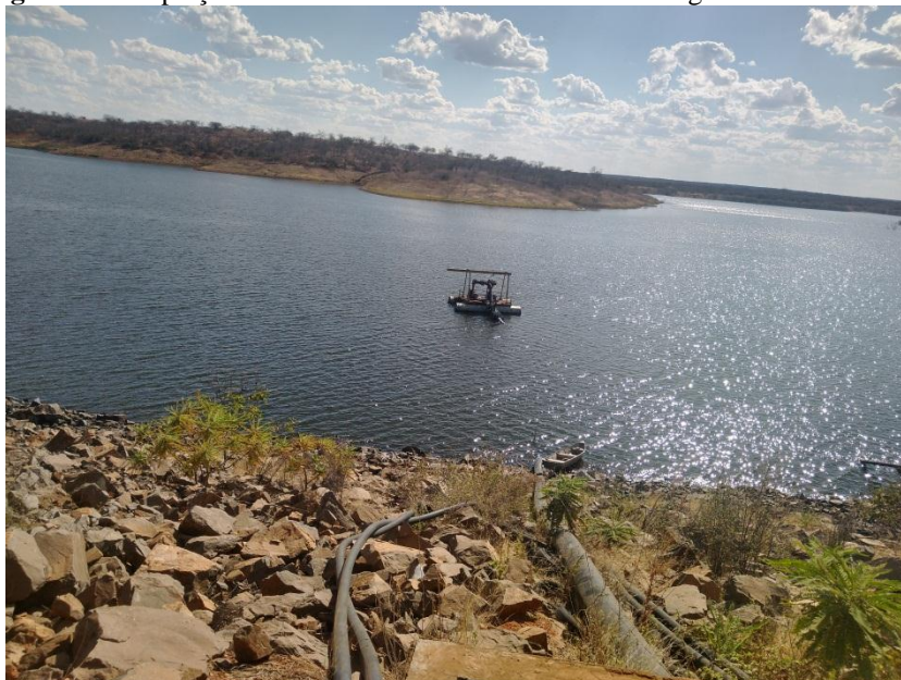
Figura 14 - Captação do Sistema Adutor Garrincho na barragem Petrônio Portela
