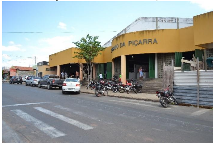
Figura 6- Fachada do Mercado da Piçarra localizado em Teresina, Piauí.
