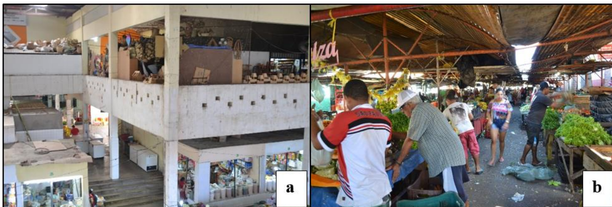
Figura 3 – Pavimento interno (a) e pavimento externo (b) do Mercado Central São José em Teresina, Piauí.
