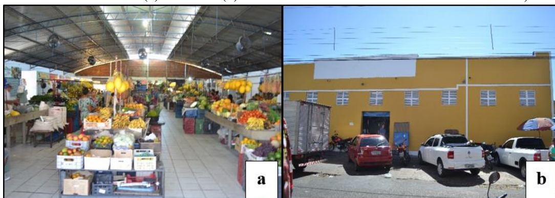
Figura 2 – Estrutura interna (a) e fachada (b) do Mercado Público Tersandro Paz em Teresina, Piauí.
