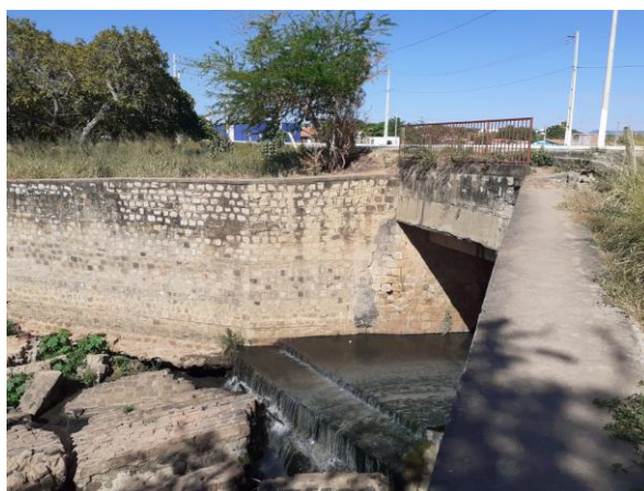
Figura 42 – Vala de Esgoto no Rio Parnaíba
