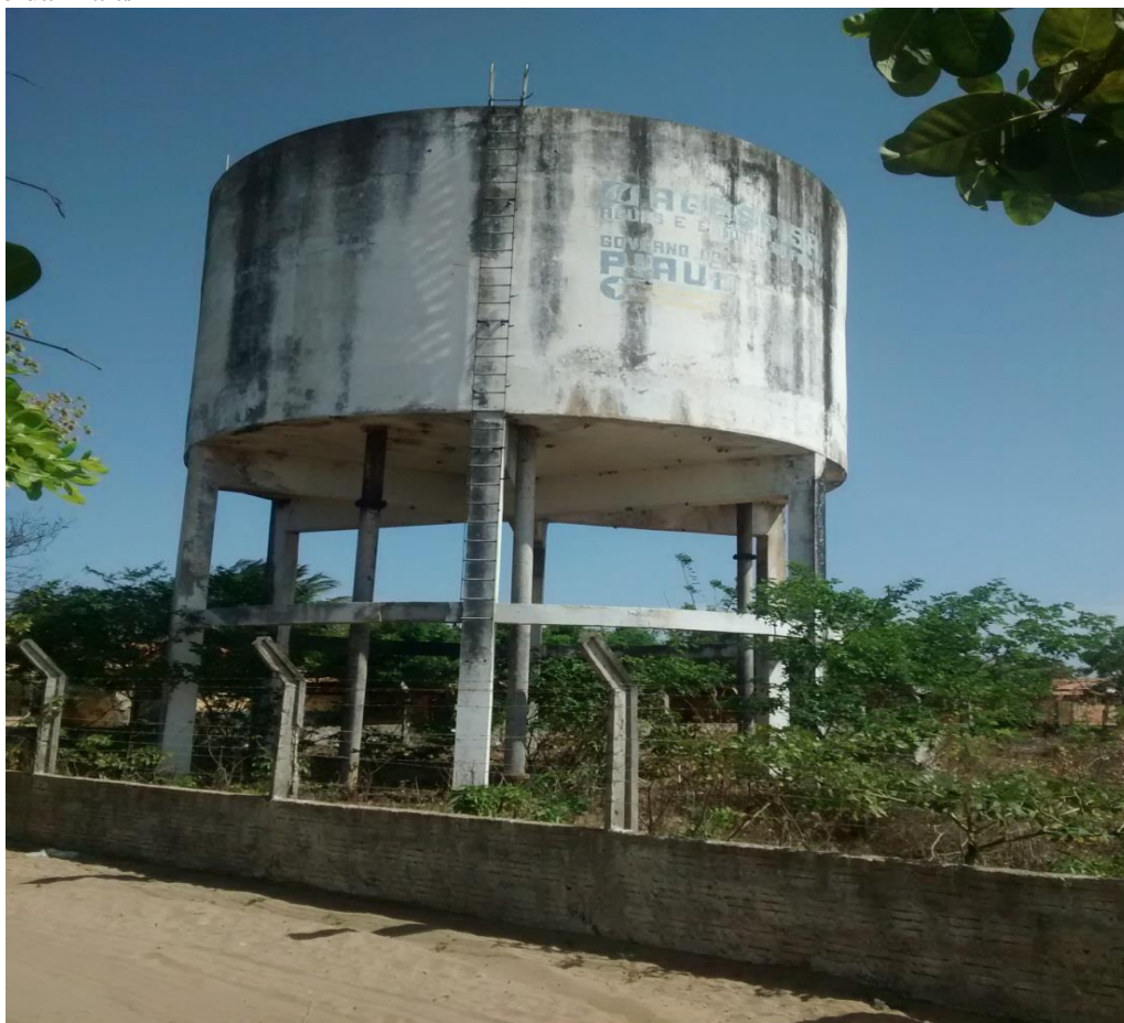
Figura 15 - Fotografia do reservatório de água da AGESPISA - na Comunidade de Barra Grande - Cajueiro da Praia/PI
