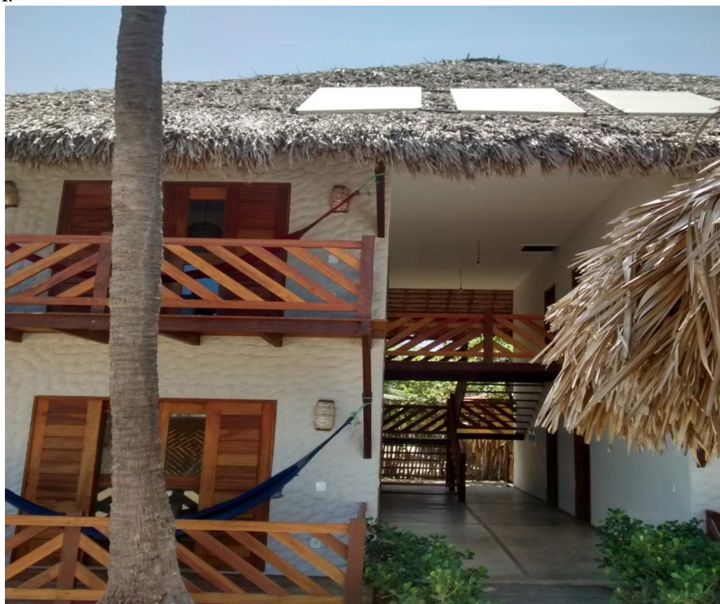
Figura 25 - Fotografia de painéis solares em pousada na Comunidade de Barra Grande - Cajueiro da Praia/PI.
