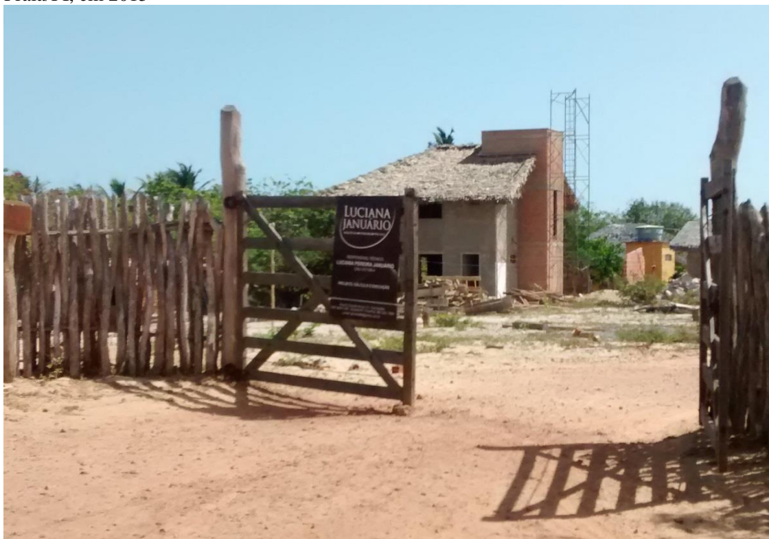
Figura 10 - Fotografia de pousada sendo construída na Comunidade de Barra Grande - Cajueiro da Praia/PI, em 2015
