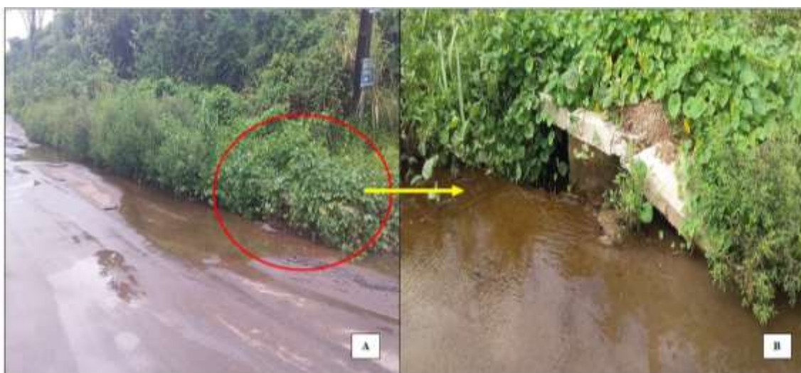
Figura 16: Afluentes oriundos do bairro satélite para o córrego do bairro Morros. A: Localização da galeria na esquina da rua do outro lado do córrego. B: Identificação da galeria.
