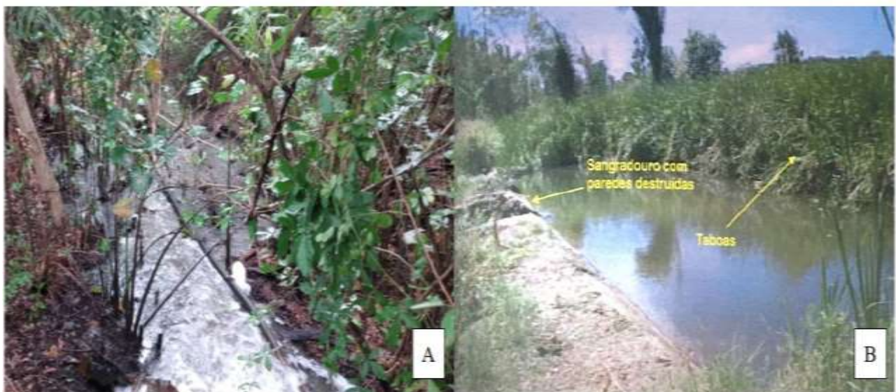
Figura 19 - Processos erosivos nos sangradores da lagoa dos Morros. A: Sangradouro da lagoa referente ao P5. B: Sangradouro da lagoa referente ao P6.
