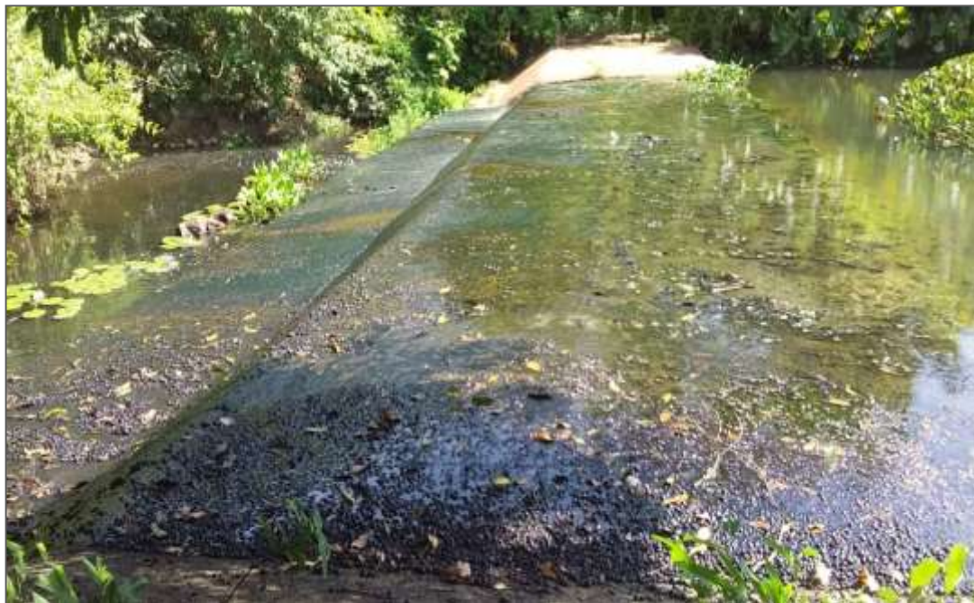
Figura 20 - Dique construído no sangradouro da lagoa dos Morros.
