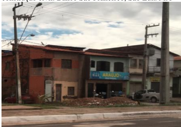
Fotografia 87 Descarte irregular resíduos da construção civil. Bairro São Francisco, São Luís/MA
